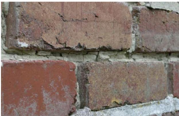
**3** Dégradation très importante du mortier de pose causée par le gel.
