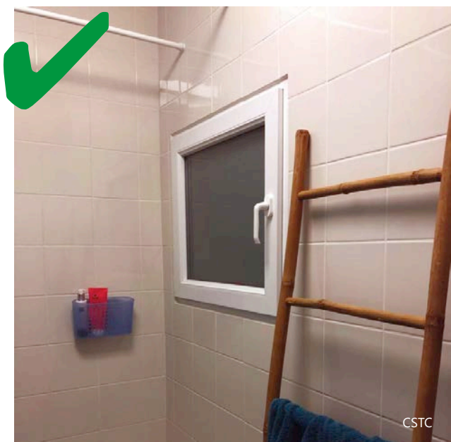
3 | Dans les immeubles à appartements, il est important de fermer les ouvertures vers les gaines techniques.
