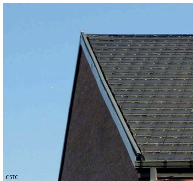
2 | Finition des rives de toiture à l'aide d'un profilé spécifique.
