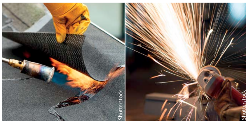
1 | Exemples de travaux 'par point chaud' réalisés sur chantier.
