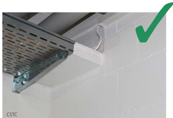
2 | Exécution correcte d'une traversée de paroi résistant au feu par un chemin de câbles.
