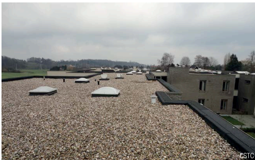
2 | Etanchéité de toiture lestée et donc aisément démontable.
