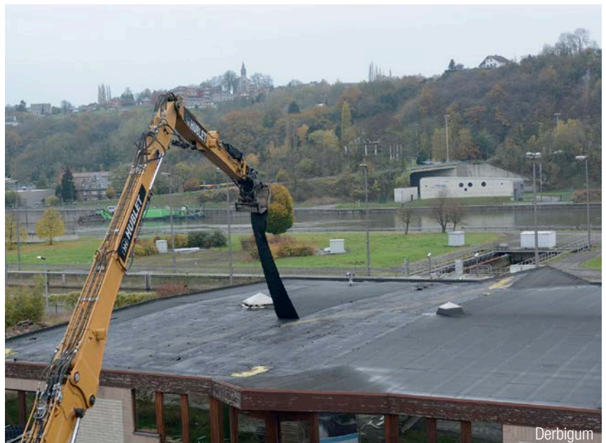
1 | La démolition sélective d'une toiture permet de recycler davantage.
