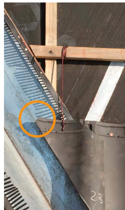
3 | Les tuiles sont sciées, épaulées et fixées au voligeage.
