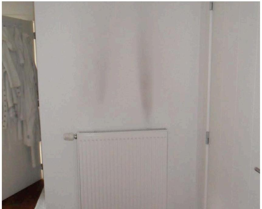
1 | Dépôts noirs visibles au-dessus d'un élément de chauffage.
