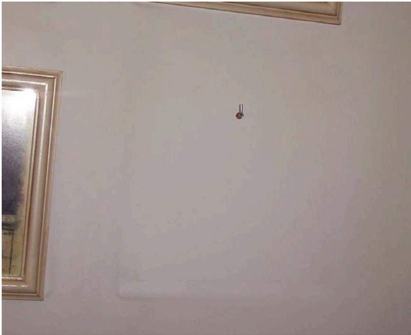
2 | Dépôts noirs observables sur l'enduit intérieur d'un mur extérieur après que l'on a retiré un cadre.
