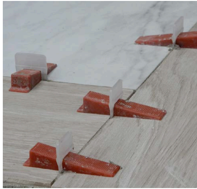
3 | Pose de cales biseautées sur un revêtement en imitation parquet.
