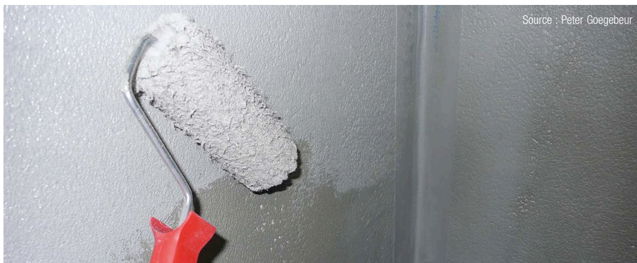
1 | Mise en œuvre d’une étanchéité liquide.
