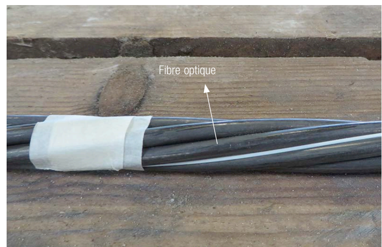
2 | Toron de précontrainte muni d'une fibre optique
