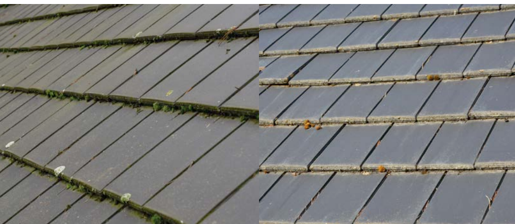
1 | A gauche : toiture en tuiles avant l'application d'un produit à base d'enzymes; à droite : une semaine après le traitement
