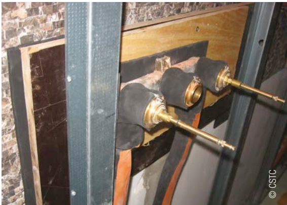
4 | Fixation des robinets et des conduites dans la coulisse d'une paroi de doublage
