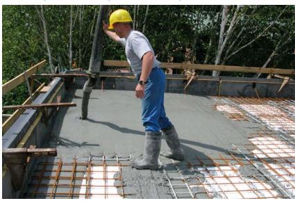
2 | La consistance (slump flow) est une caractéristique minimum à spécifier lorsqu'on commande un béton autocompactant.
