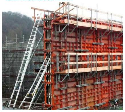
5 | La hauteur de chute du béton autocompactant doit être limitée pour éviter la ségrégation et les inclusions d'air.
