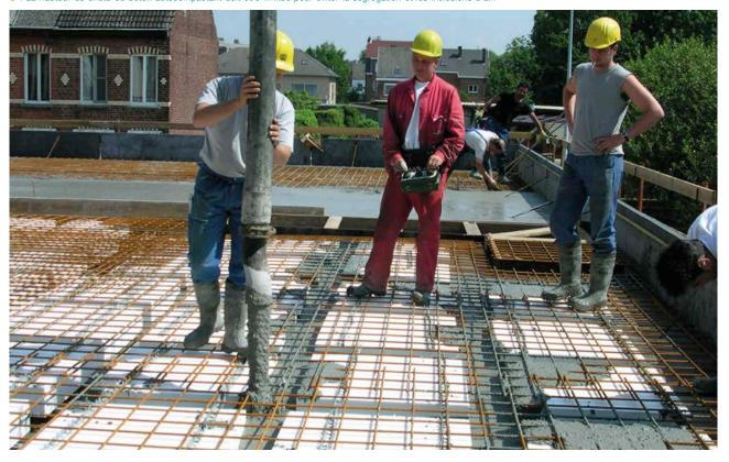
il s'avère nécessaire de limiter la hauteur de chute (< 1 mètre) pour éviter la ségrégation et les inclusions d'air. De plus, le cheminement horizontal dans le coffrage ne peut pas être trop long (5 à 10 mètres selon le type de béton).
