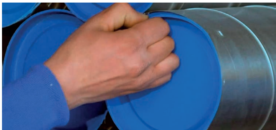
Exemple de conduits bien protégés durant le stockage
