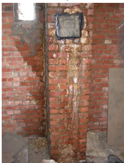
1 et 2 | Apparition de taches d'humidité dans un parachèvement intérieur et le long d'un conduit de fumée
