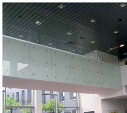
4 | Exemple d'encastrement par fixations ponctuelles
