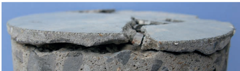
Délaminéation d'une couche de béton
