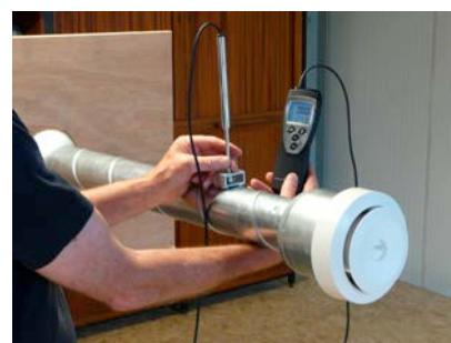
20 | La mesure est réalisée de la même manière que la mesure en conduit.
