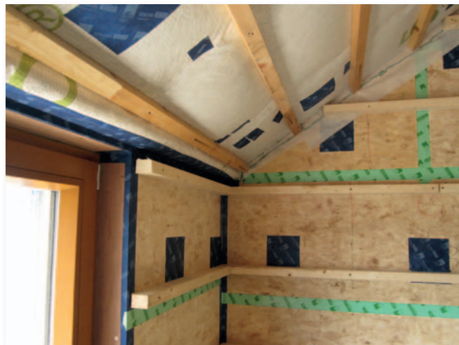
Fig. 1 Les joints et percements dans le revêtement intérieur en panneaux de bois sont rendus étanches au moyen de bandes adhésives.
