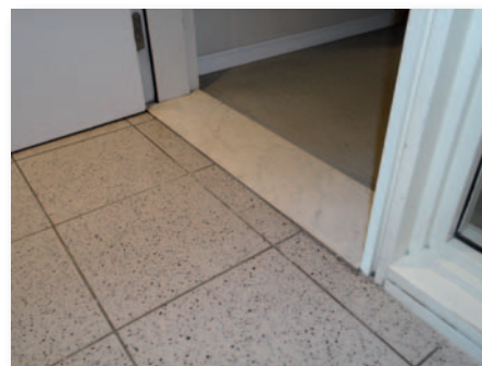
Fig. 2 Exemple de pose d'un seuil en pierre
