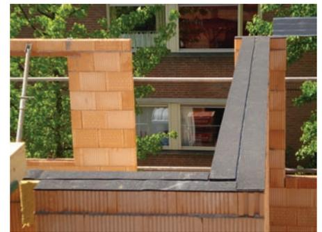
**Fig. 2** Les bandes en matériau résilient (en noir sur la photo) assurent une coupure acoustique entre les dalles de béton et le reste de la structure.
