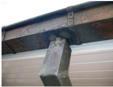
Corrosion à hauteur du raccord entre le tuyau de descente et la gouttière.
