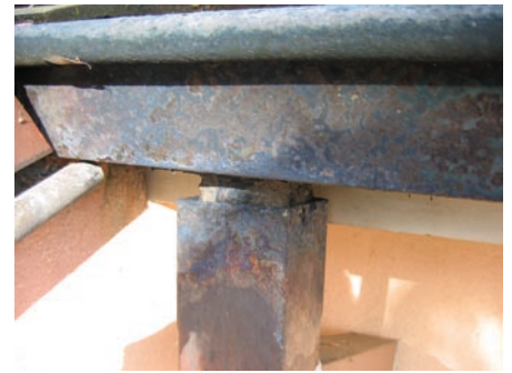
Corrosion à hauteur du raccord entre le tuyau de descente et la gouttière.
