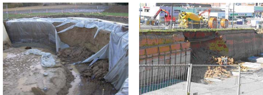
Fig. 2 Exemples de ruptures de pentes brutales et imprévues.
