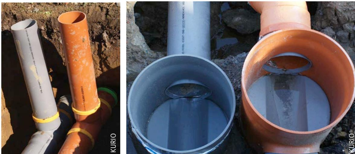
Fig. 1 Les eaux pluviales et les eaux usées doivent être évacuée séparément sur la parcelle.
