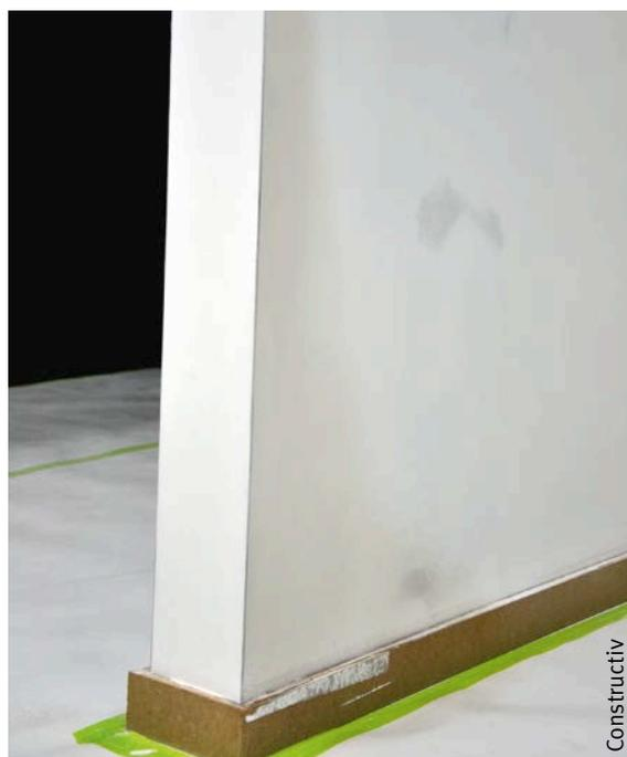
Fig. 1 Humidité dans un mur enduit.
