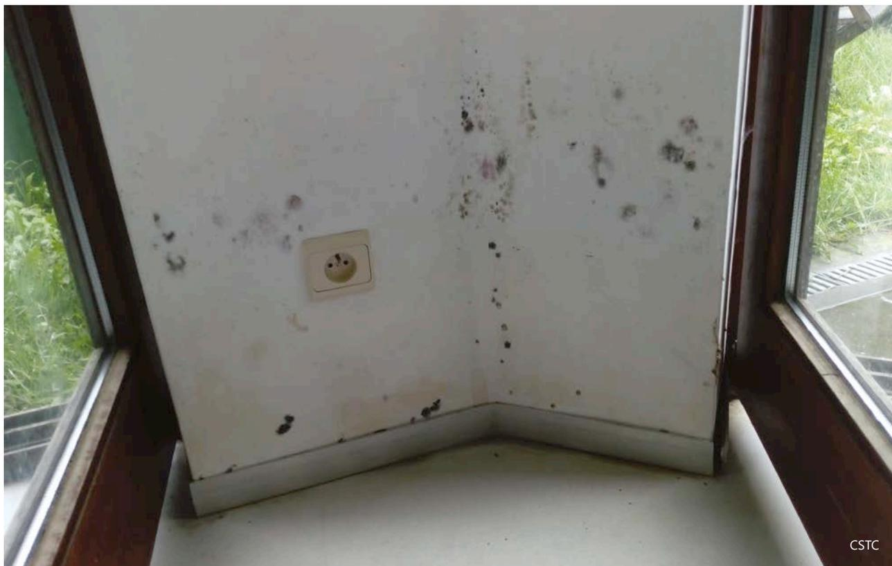
ou si le séchage est entravé par des couches de finition ou des conditions défavorables. Des simulations numériques réalisées au moyen du logiciel Delphin montrent que le temps de séchage peut être multiplié par trois en présence de finitions comme des peintures. Ce temps de séchage sera encore accentué si on maintient un éventuel isolant sur la face intérieure de la maçonnerie.
