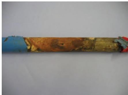
Fig. 3 Corrosion externe par aération différentielle.
