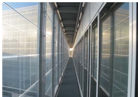
Fig. 1 Double façade ventilée.
