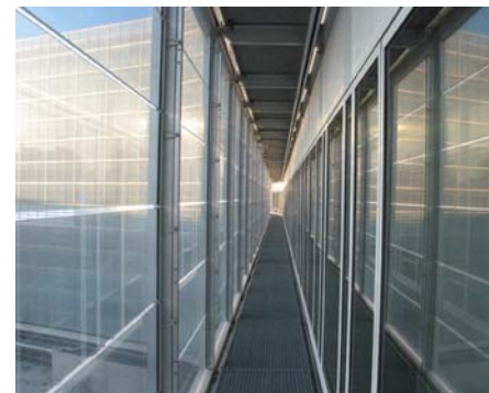
Fig. 2 Double façade ventilée.
