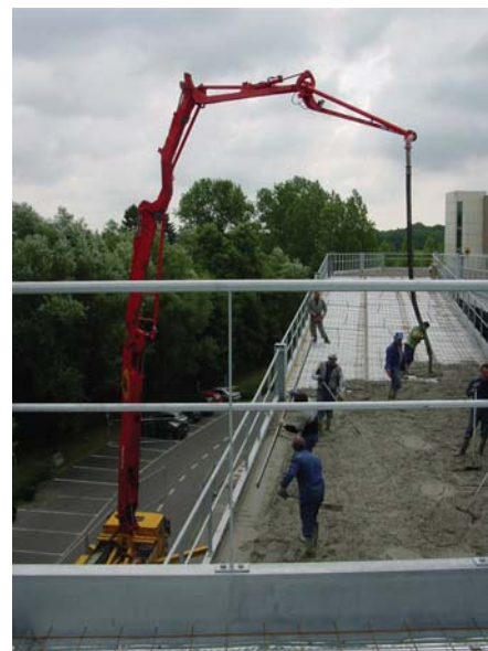
Coulage du béton sur une tôle profilée écrouie à froid.
