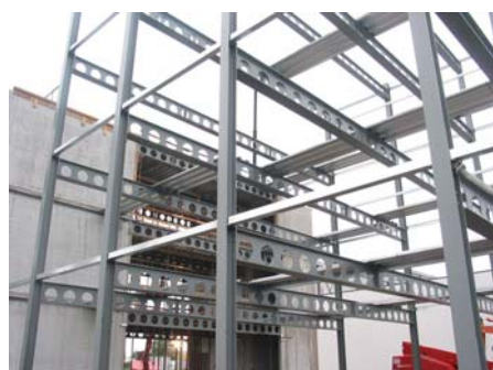
Mise en œuvre dans un bâtiment multi-étagé.
