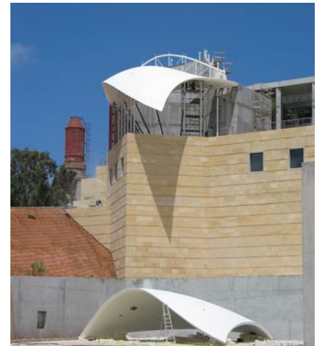
La toiture du monument dédié à la mémoire de Yitzhak Rabin est composée de polyester renforcé de fibres de verre et d'EPS.
