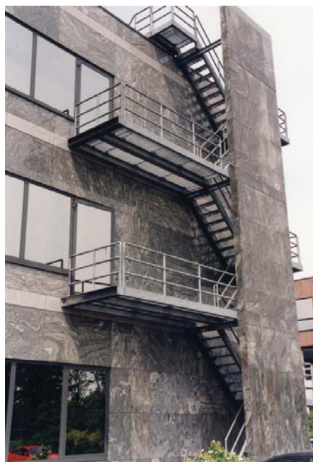
Façade en pierre naturelle.
