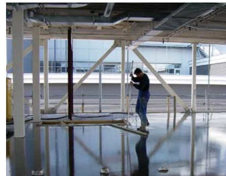
Désaération et lissage d'une chape fluide.
