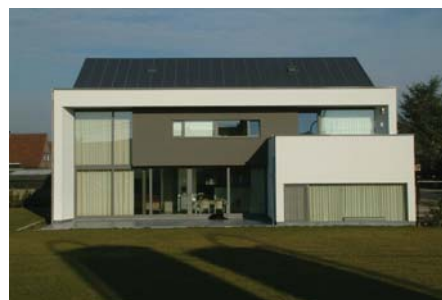
Système d'enduits sur isolant sur la façade d'une habitation.
