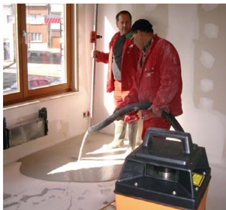
Fig. 1 Mise en œuvre d'une chape sur un plancher en bois.
