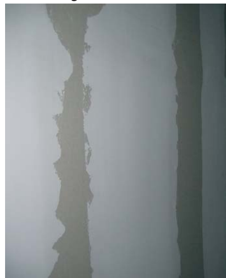
Fig. 1 Exécution d'un jointoiement selon le degré de finition Q2.
