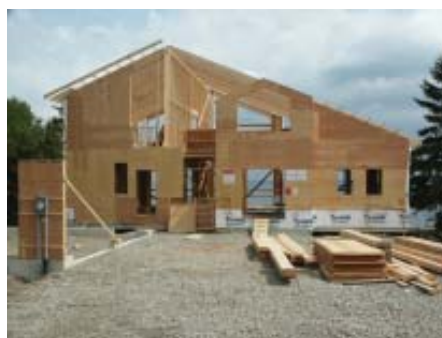
Fig. 1 La construction à ossature en bois : souvent desservie par une isolation acoustique médiocre.
