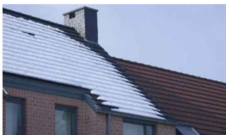
Abb. 1 Durch gute Luftdichtheit und gute thermische Isolation kann man den Wärmeverlust durch die Dachabdeckung begrenzen.
