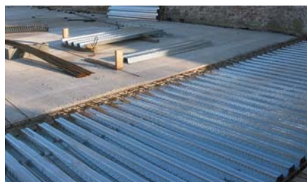
Stahlplatten-Betonboden während der Ausführungsphase.
