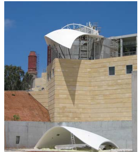
Denkmal für Yitzhak Rabin, das mit einer Dachkonstruktion aus glasfaserverstärktem Polyester und EPS ausgerüstet ist.
