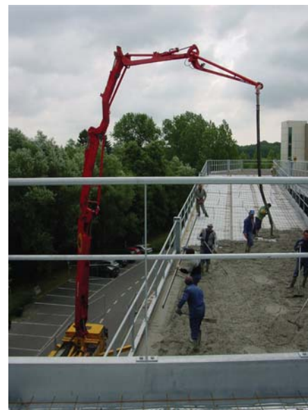
Gießen von Beton auf kaltverformte profilierte Stahlplatten.
