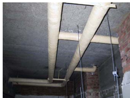
Abb. 2 Wärmeisolierung von Leitungen.
