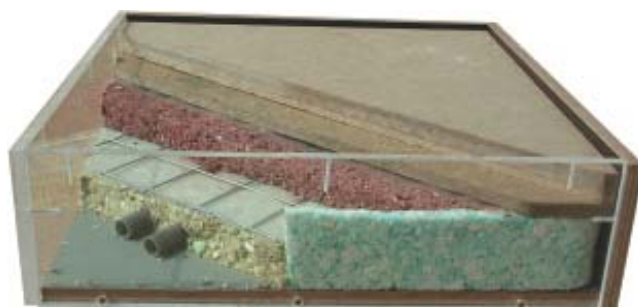
Maquette du sol d'un local de l'étage : on aperçoit la sous-chape en déchets de polyuréthane, la chape en déchets de polyuréthane et de ciment ainsi que le revêtement constitué de deux panneaux de dureté différente, à base de déchets de bois.
