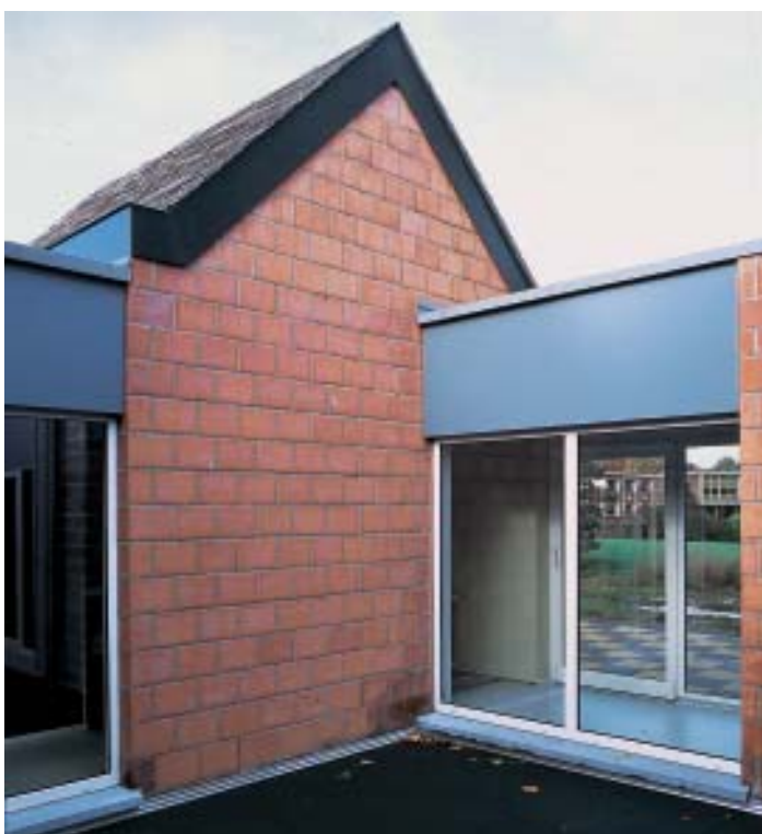
Vue du patio entre les annexes et le bâtiment principal : sol en dalles drainantes de caoutchouc recyclé, murs en blocs de terre cuite avec déchets de polystyrène expansé, planches de rive en laine de roche recyclée et comprimée, couverture en déchets plastiques ménagers recyclés.
